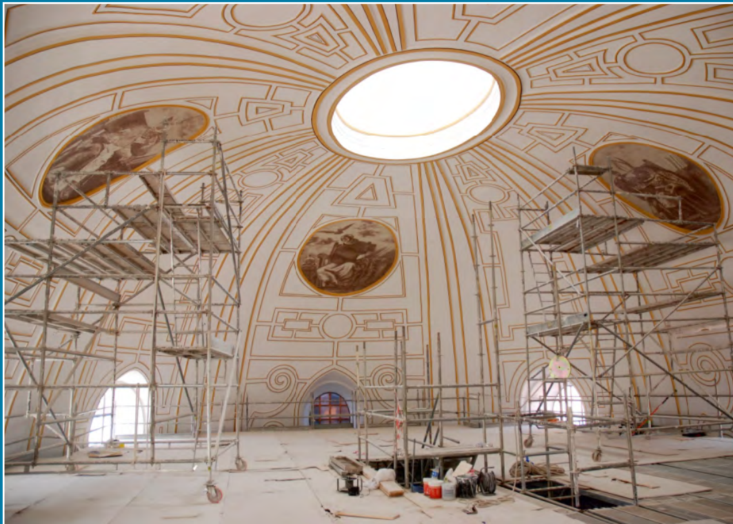
MARFIL - RECONSTRUCCIÓN DE LA CÚPULA IGLESIA DE LAS BERNARDAS
